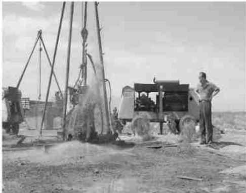
照片 1 洗井现场
